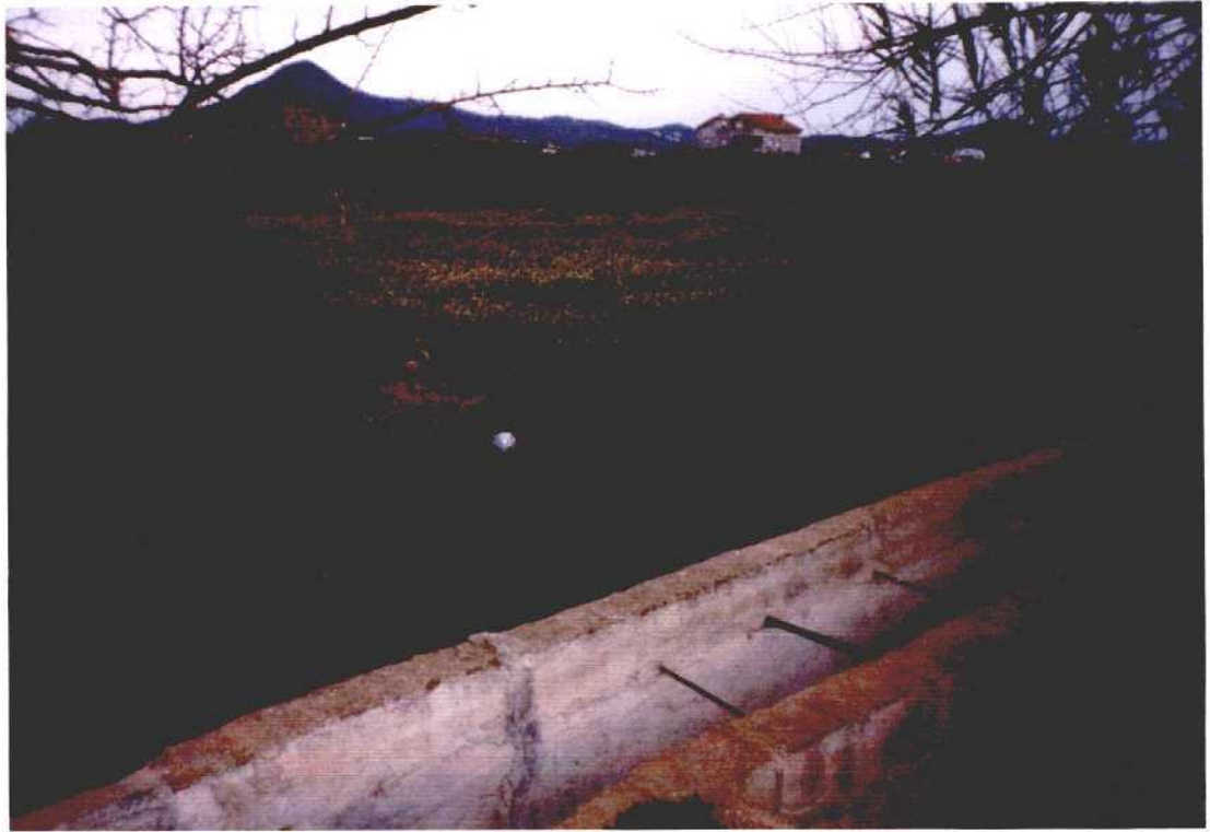
Vista general de la parcela en la que está emplazada la batería RA3.
